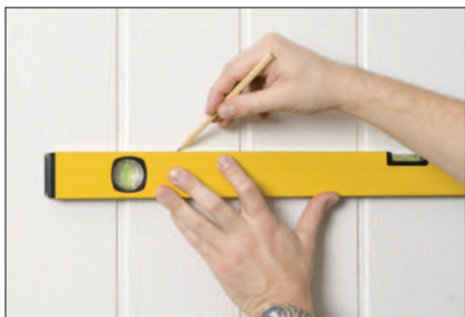
Schritt 1 Anzeichnen. Empfohlene Höhe für den Stehtisch: 110 cm, für den Esstisch: 76 cm.
