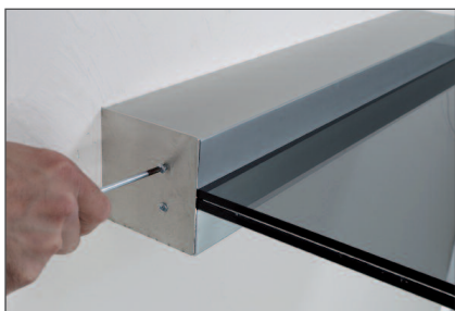
Schritt 13 Endkappen verschrauben
