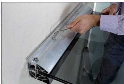
Schritt 10 Fixierung der Schrauben mit 40 Nm
