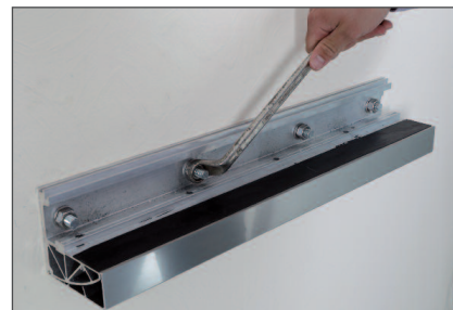
Schritt 3 Anbringung der Aluminium-Leiste mit Qualitätsschrauben. Fixierung.
