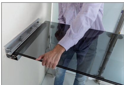
Schritt 4 Auflegen der Glasplatte
