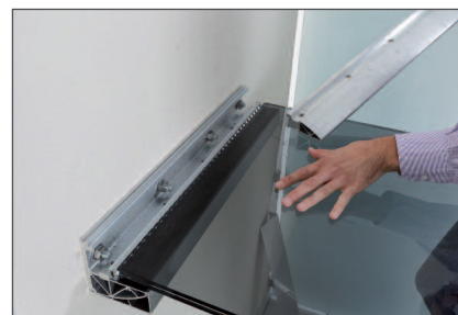
Schritt 6 Glas bündig zur Wandklemmleiste schieben
