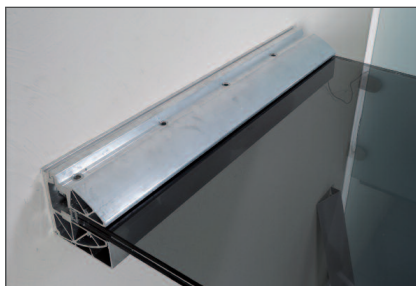
Schritt 8 Profile bündig übereinander ausrichten
