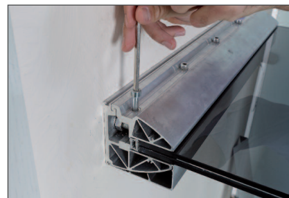
Schritt 9 obere Leiste gleichmäßig fest- schrauben und Schrauben fixieren
